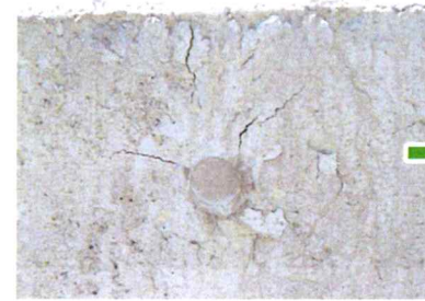
▼平成16年5月 施工前
