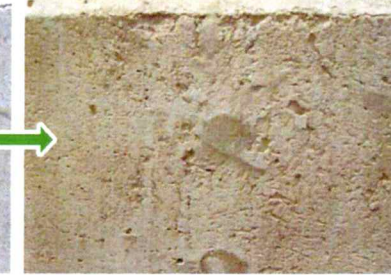
▼平成22年6月 施工後
