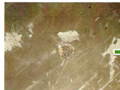
▼施工前 平成22年8月
