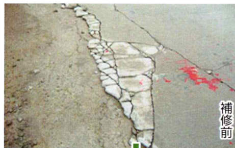
▼ばらばらになったコンクリートの補修例
