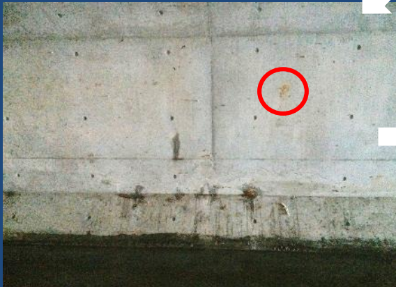
3 シッカリート投入後止水反応中
