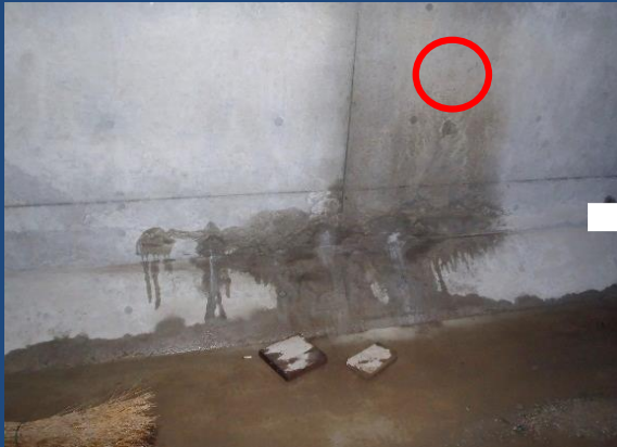
3 シッカリート投入後止水反応中
