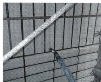
タイル目地に塗布するとタイルの付着強度がUPします。
