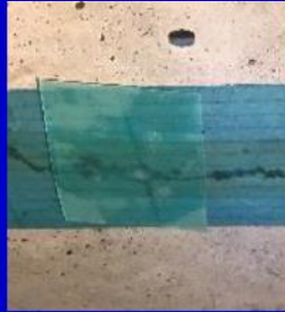
充填状況目視確認
